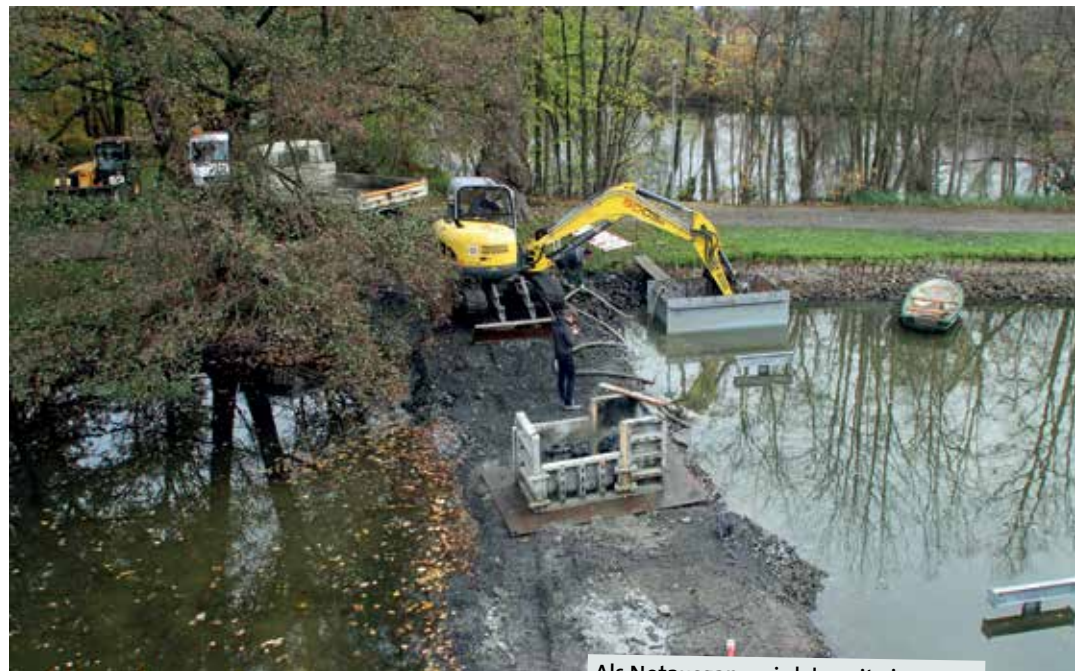
Als Notausgang wird derzeit eine Unterwassersteg in die Gräfte gebaut.
